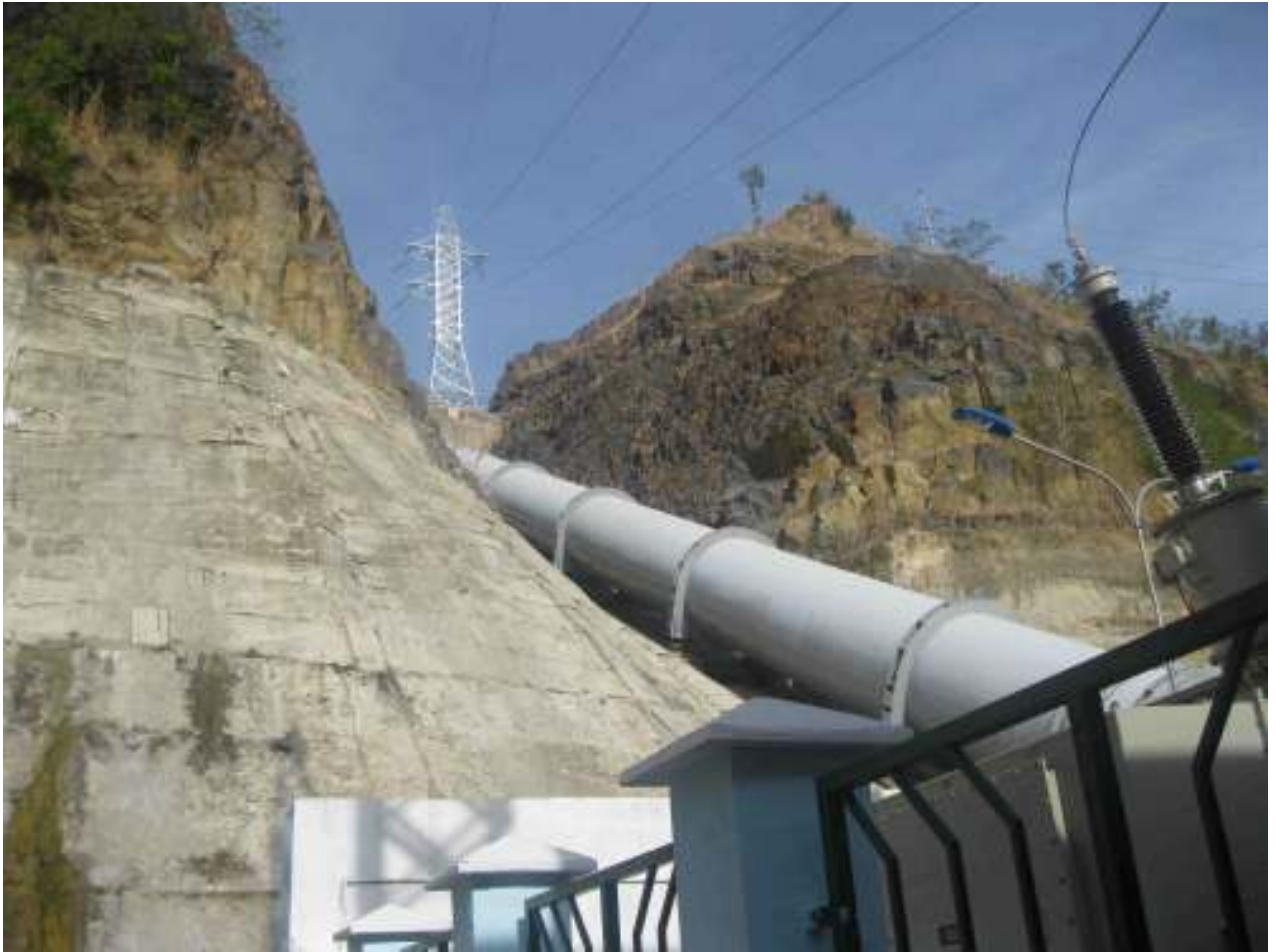
Ảnh: Đường ống áp lực & đường dây cao áp đầu nối thủy điện H'Mun vào hệ thống điện QG
