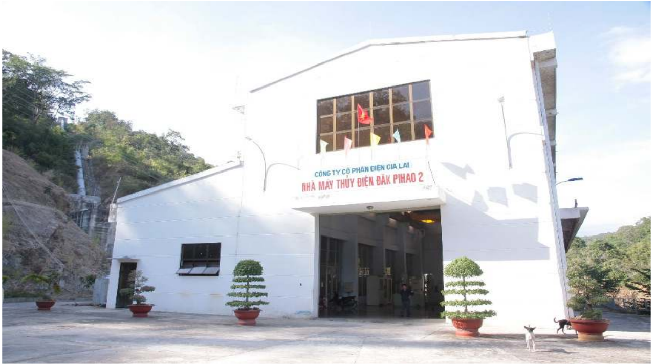
Ảnh: Nhà máy ĐăkPiHao2 công suất 9 MW, TIC liên doanh đầu tư - đưa vào hoạt động từ năm 2007
